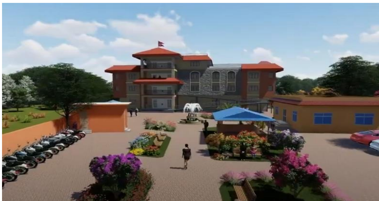
निर्माणाधीन प्रशासकीय भवन
